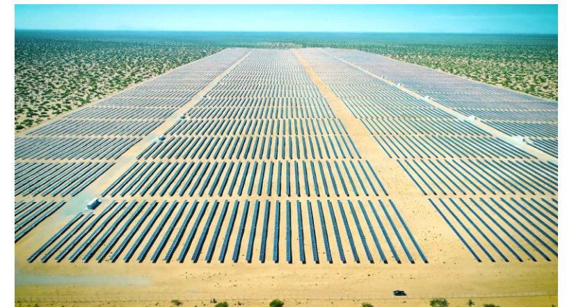
▲ 65 MW 墨西哥 / Mexico 中来FFC背板 (建设于2015年) / Jolywood FFC Backsheet (Built in 2015)
