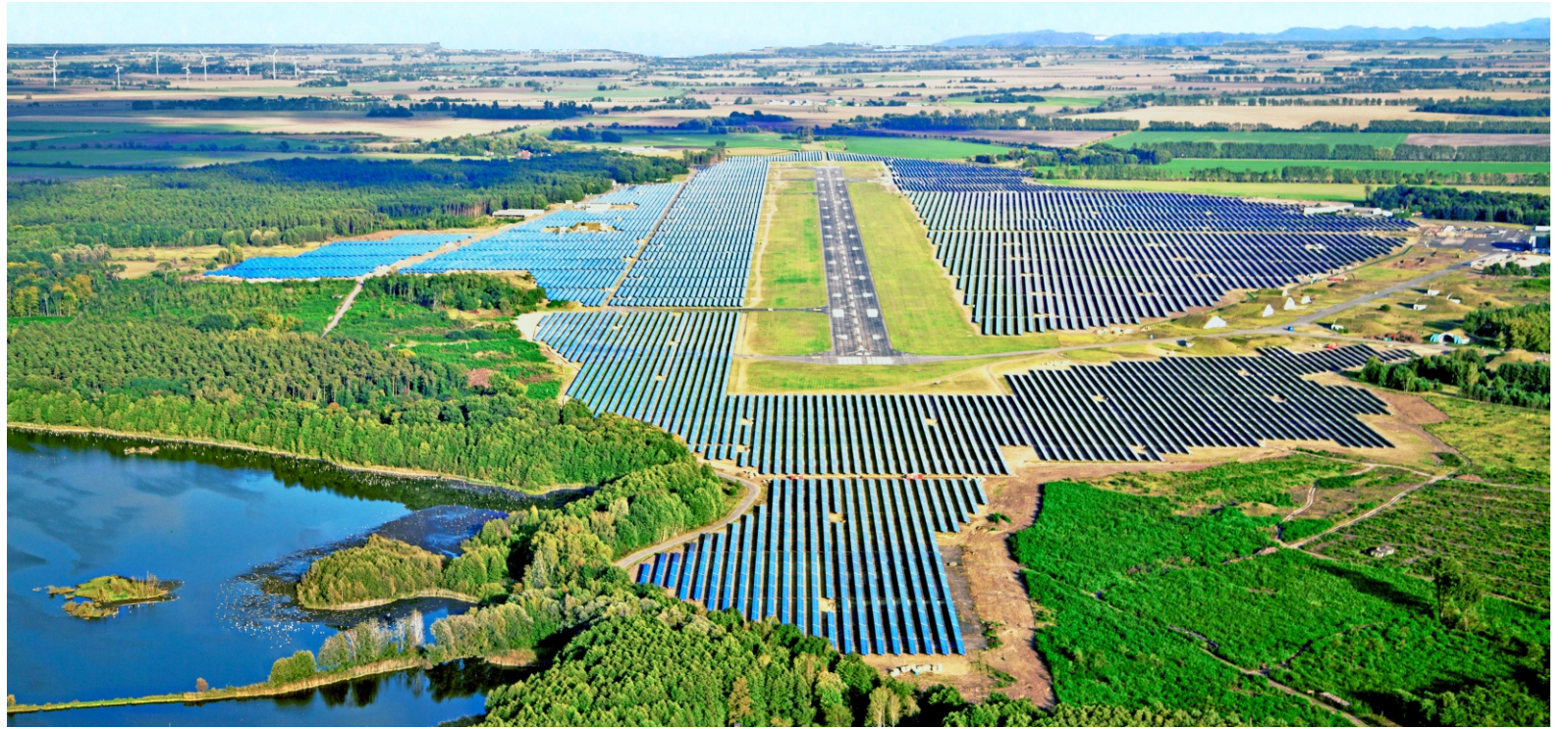
▲ 20 MW 德国 / Germany 中来FFC背板 (建设于2012年) / Jolywood FFC Backsheet (Built in 2012)
